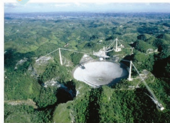
Figura 21.9 El radiotelescopio de Arecibo, en Puerto Rico, tiene un diámetro de 305 metros. Su gran tamaño permite captar ondas de radio muy débiles que provienen del espacio. Los radiotelescopios abarcan longitudes de onda que van de 0.3 mm hasta 20 m
