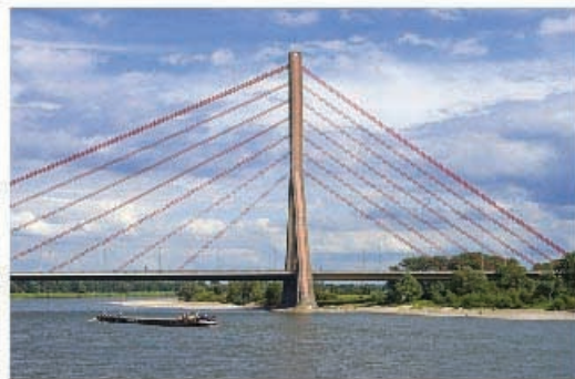
Figura 12.2 Los sistemas de fuerzas en equilibrio aplicados en puentes atirantados mantienen en reposo cada uno de los elementos que los constituyen.
